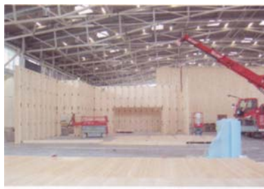
Montage et démontage des panneaux modulaires porteurs
