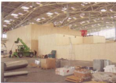
Montage et démontage des panneaux modulaires porteurs
