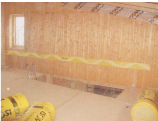
Réutilisation après l'événement, des panneaux porteurs (fabriqués industriellement en bois multiplis contrecollés) du centre des médias, dans la construction d'une maison individuelle
